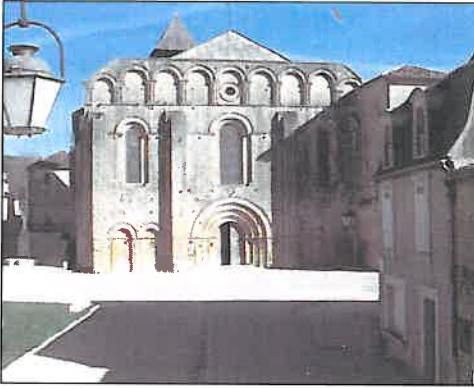
Fig. 1 - La façade de l'abbatiale de Cadouin
